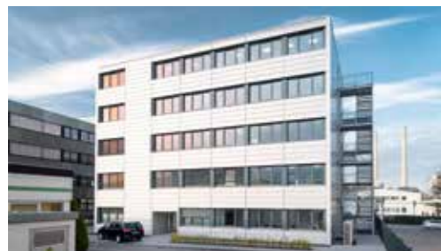
Neckarsulm , 5-geschossiges Bürogebäude, BGF 1.385 m 2
