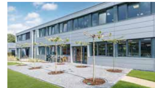
Coesfeld , 2-geschossiges Bürogebäude, BGF 1.021 m 2
