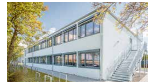
Germering , 2-geschossiges Schulgebäude, BGF 1.065 m 2
