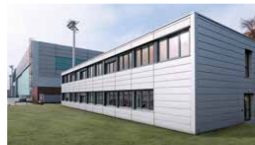
Wunstorf , 2-geschossiges Bürogebäude, BGF 870 m 2
